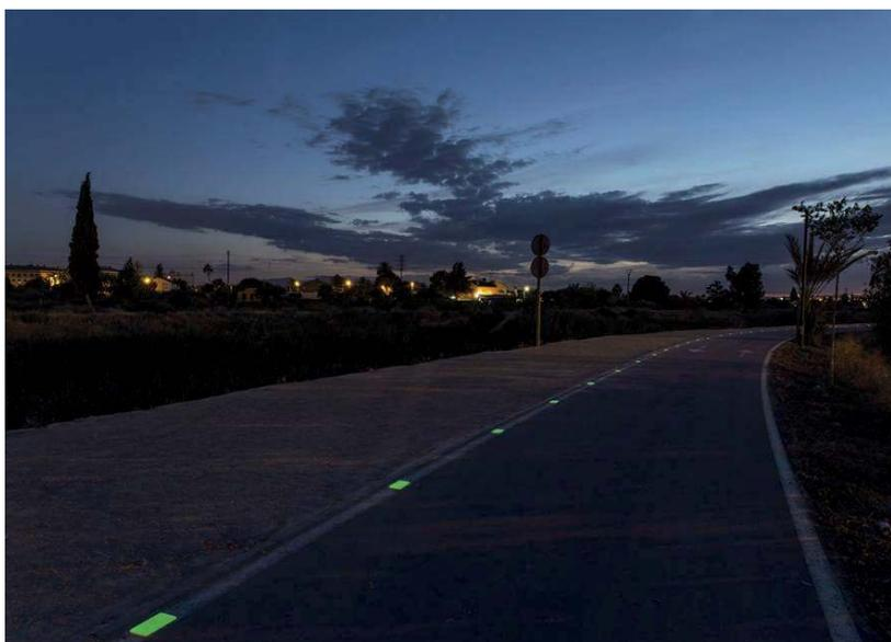
Figura 1. Losetas UFL sobre bordillos de hormigón, fijación mediante resinas.
