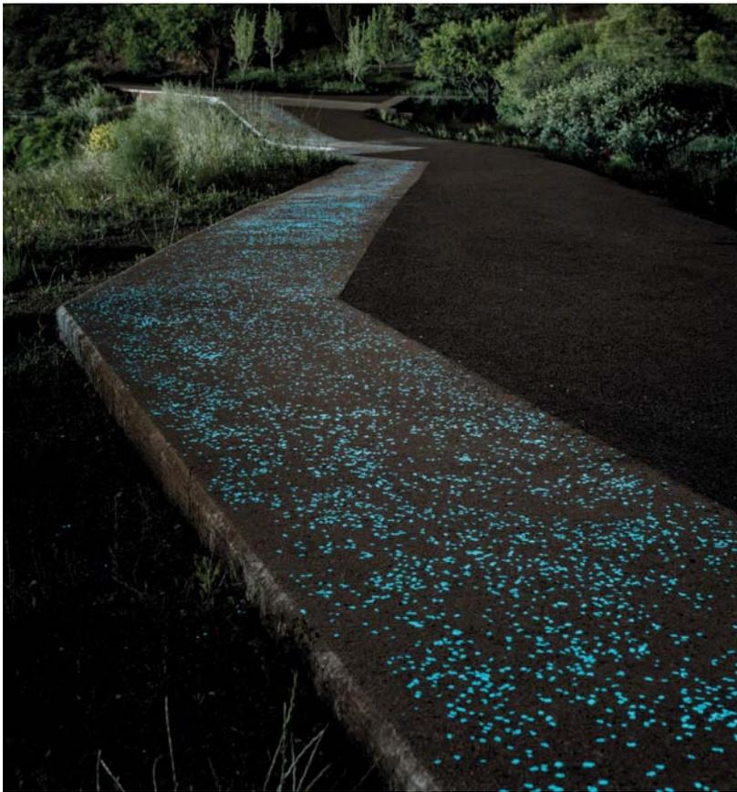
Figura 10. Losa de hormigón fotoluminiscente. Foto: Jordi Surroca.
