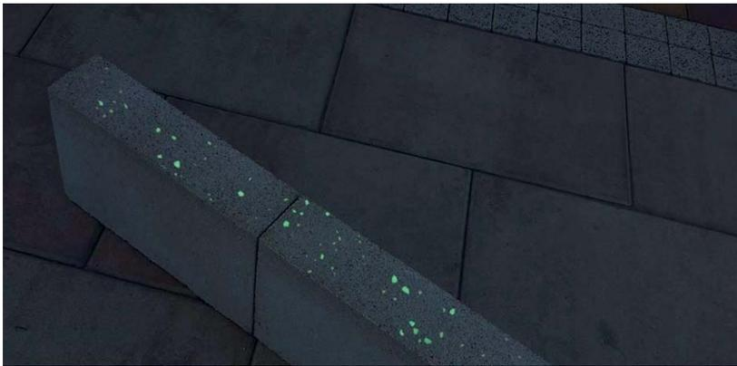
Figura 3. Bloque prefabricado de hormigón con huellas ultrafotoluminiscente.
